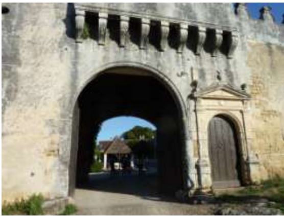
Château de Garde-Epée à Saint Brice
