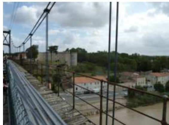
Vue du pont suspendu de Tonnay - Charente
